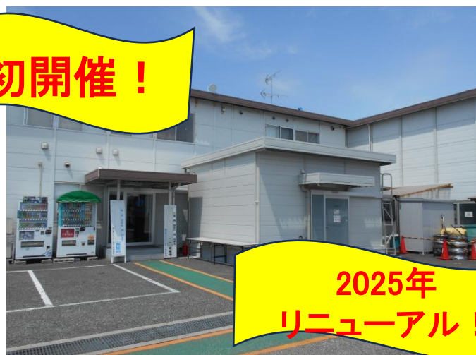
神戸営業所 (神戸市中央区港島4丁目6-2)
